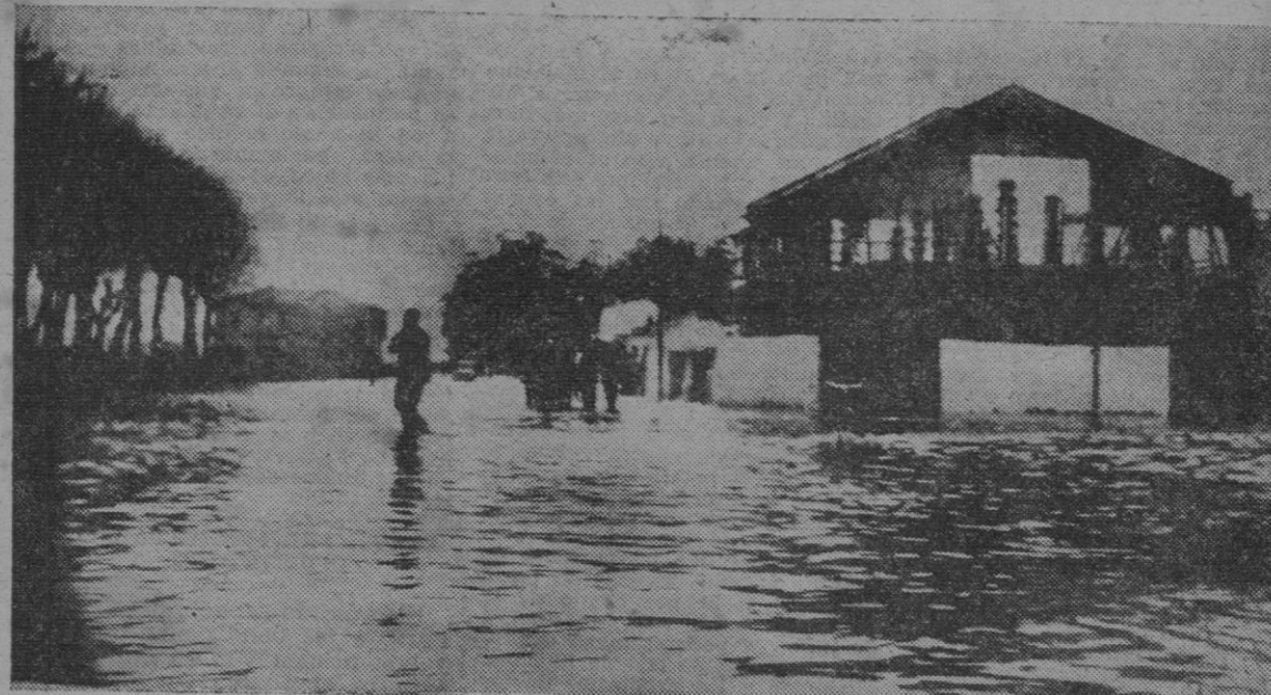
La desviación de la carretera Coruña-Vigo, a su paso por Padrón, cubierta casi totalmente por las aguas desbordadas del Sar. — (Foto MONCHO)
