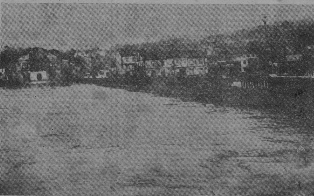
Los trece arcos del puente de Cesures, ocultos por la importante crecida del Ulla. El trozo de barandilla rota fué a consecuencia de un choque entre dos automóviles, ocurrido hace unos meses y todavía sin reparar. — (Foto MONCHO)
