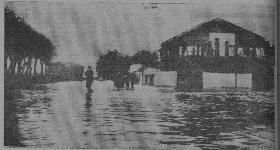
La desviación de la carretera Coruña-Vigo, a su paso por Padrón, cubierta casi totalmente por las aguas desbordadas del Sar. — (Foto MONCHO)
