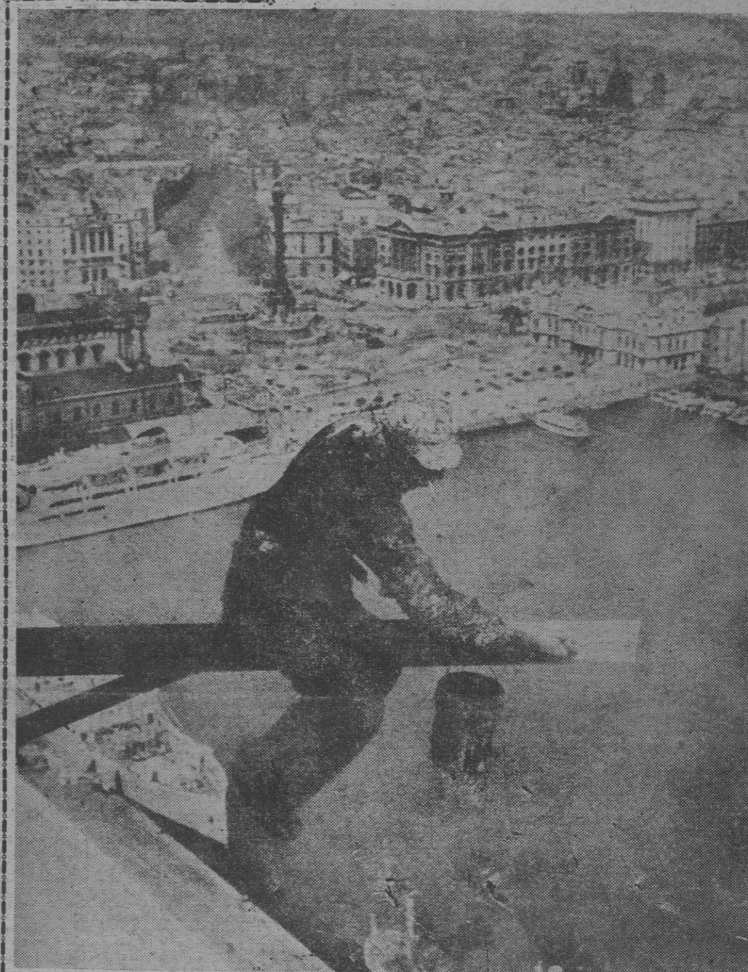
Sobre el puerto de Barcelona, a sesenta metros de altura, un obrero pinta y fuma con toda tranquilidad. Es uno de los operarios que restauran la torre de Jaime I, para que el funicular Miramar-Montjuich funcione de nuevo.
