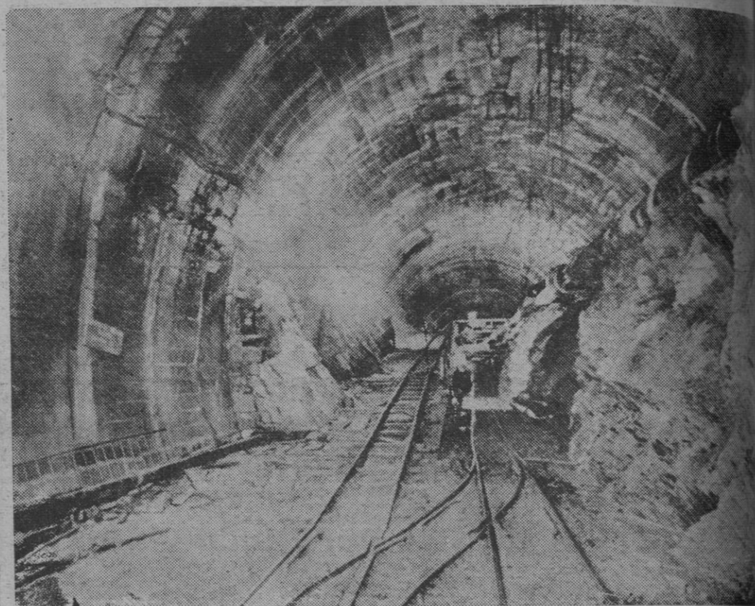
Un detalle de las obras en el túnel del Gran San Bernardo. (Foto Europa Press).
