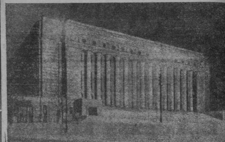
Soberbio edificio de la Dieta finlandesa, en Helsinki
