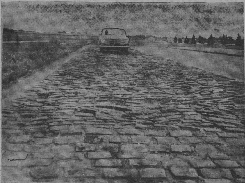
Prueba de resistencia de un coche en una sección de carretera muy estropeada, en el Centro experimental de la Asociación para la Investigación de la Industria del Automóvil, en Nuneaton.
