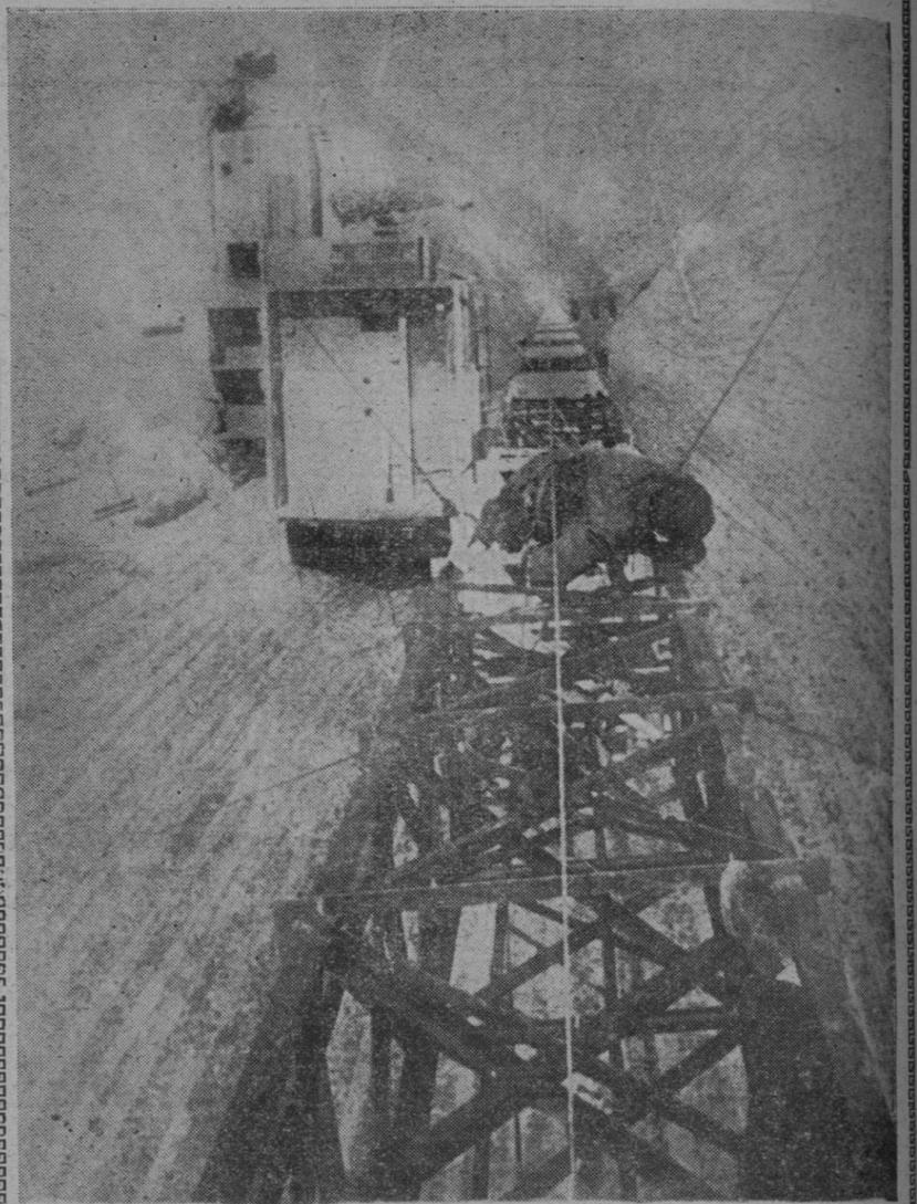
AVILA. — Obreros especializados realizan el arriesgado trabajo del montaje y reparación en las torres de las antenas de radio. La foto presenta a los obreros en acción reparando la de Radio Gredos de Avila a una altura de 125 metros. — (Foto E. P.)
