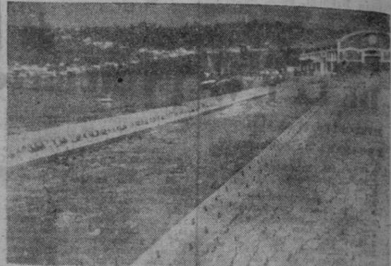
Obras en el muelle exterior de la Dársena. Afirmando especial para el paso de las grúas. (Foto «TELVIS»).
