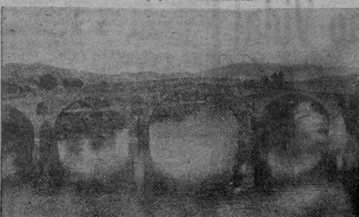
Puente de la Reina, sobre el río Arga
