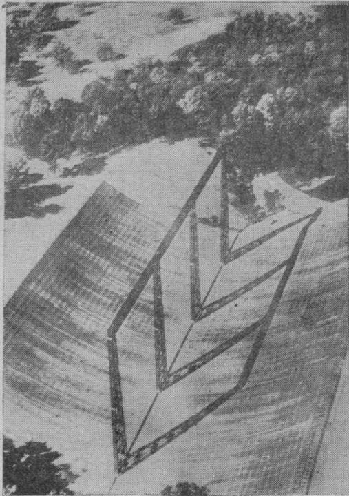
Vista aérea del enorme radio telescopio de la Universidad de Illinois, cerca del Observatorio del río Vermilion, a cinco millas de Danville (Illinois). Un enrejado ha sido formado, subiendo con malla de alambre un radio espejo de 400 pies por 600, que refleja y enfoca las señales en una línea de 276 antenas unidas por un armazón de madera de 153 pies, detrás del espejo reflector. El armazón lo soportan cuatro pilares. El telescopio será inaugurado en el presente mes.
