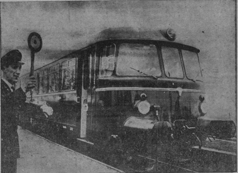
El considerable ahorro de peso y la posibilidad de la construcción según el sistema de unidades de montaje de piezas prefabricadas se recatan como las ventajas particularmente económicas del nuevo ferrocarril de plástico. Nuestra foto muestra el primer tren de este género, en cuya instalación se han empleado también casi exclusivamente plásticos.
