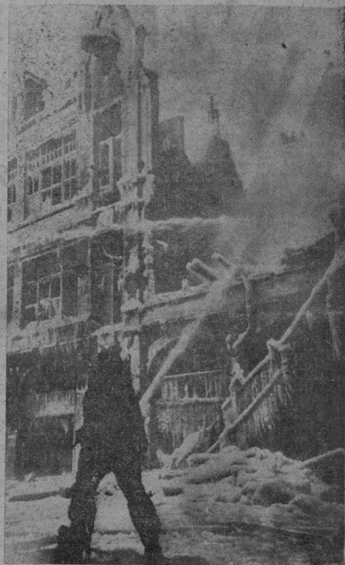
AMSTERDAM.— De este edificio destruido por el fuego cuegan miles de carámbanos, después que los bomberos arrojaron durante 16 horas el agua de las bombas sobre las llamas. El incendio, el mayor de Amsterdam desde la guerra, destruyó un almacén lleno de motocicletas y neumáticos, así con unas diez casas y varias oficinas cercanas. (Foto AP—LOGOS)
