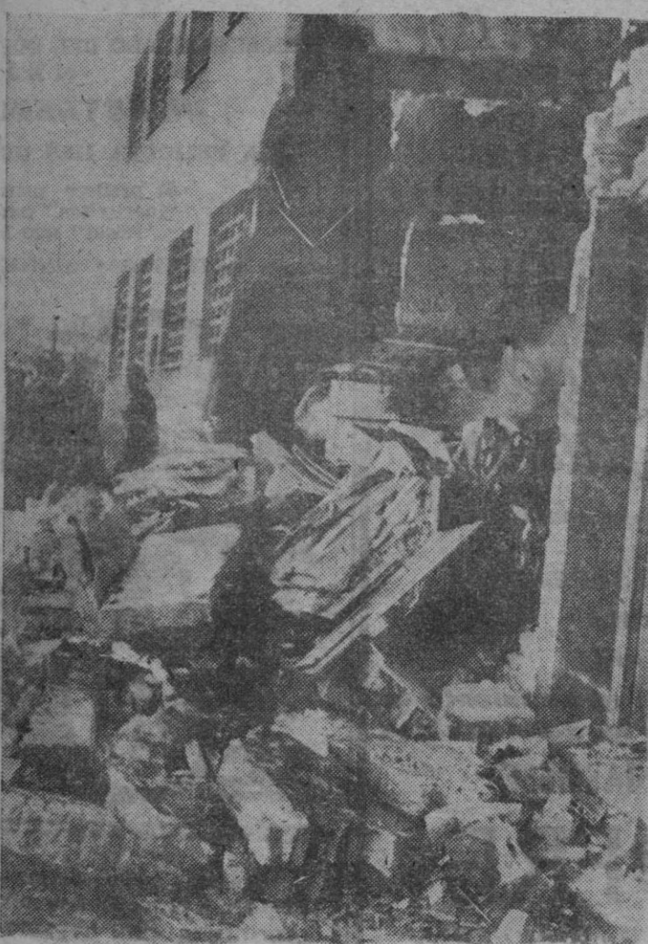
BARCELONA.- La explosión de la caldera de un taller de es- tampación, situado en la calle de Gonzalo Pons, produjo graves daños en la misma, como también heridas de consideración a dos obreros. Los efectos de la explosión se hicieron sentir en una in- dustria de artes gráficas colindantes, cuya fachada principal fue derribada por la onda expansiva. En la fotografía la fachada de la imprenta derribada. (Foto EUROPA PRESS).
