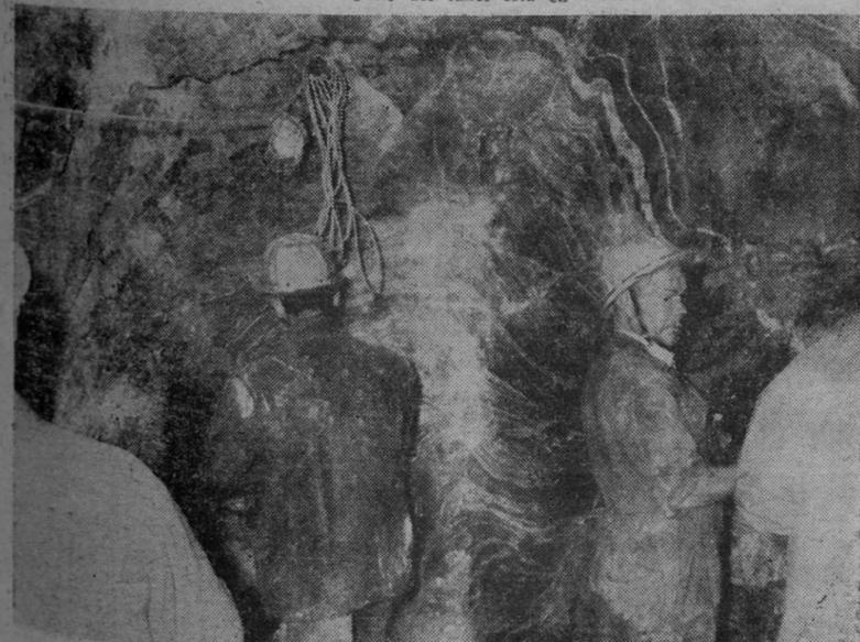
Los obreros trabajando en el interior de uno de los túneles mediante dos túneles de aproximadamente 2.000 metros de longitud, 126 metros de anchura y 50 metros de altura; cinco kilómetros de canal cubierto llevarán el agua hasta un sifón de ocho kilómetros de largo hacia los depósitos y estación depuradora de Catabois.
