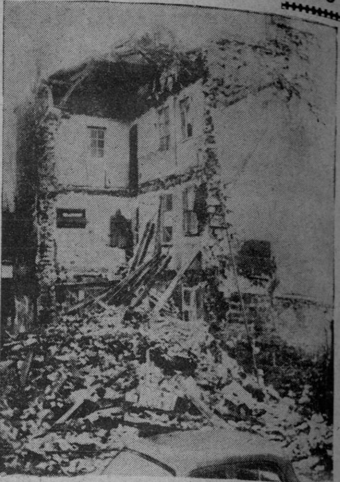
PARIS.— La violencia del viento fué tan grande en el barrio parisino de Puteaux que una casa situada en la calle de Voltaire quedó en el estado que puede apreciarse en la foto. A pesar de lo espectacular, del siniestro no hubo que lamentar desgracias personales.— (Foto Europa Press)
