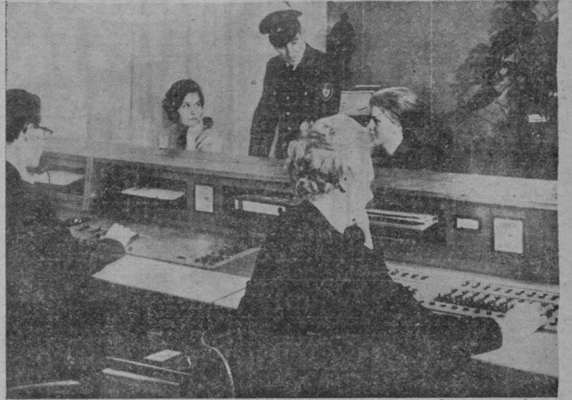
El manejo de esta central telefónica de 100 líneas principales y 1.500 líneas secundarias no requiere sino sólo cuatro personas. Las llamadas llegadas son conectadas automáticamente a una «línea» y espera» que las transmite a la empleada en el orden de sucesión de la llegada cuando su línea está desocupada.
