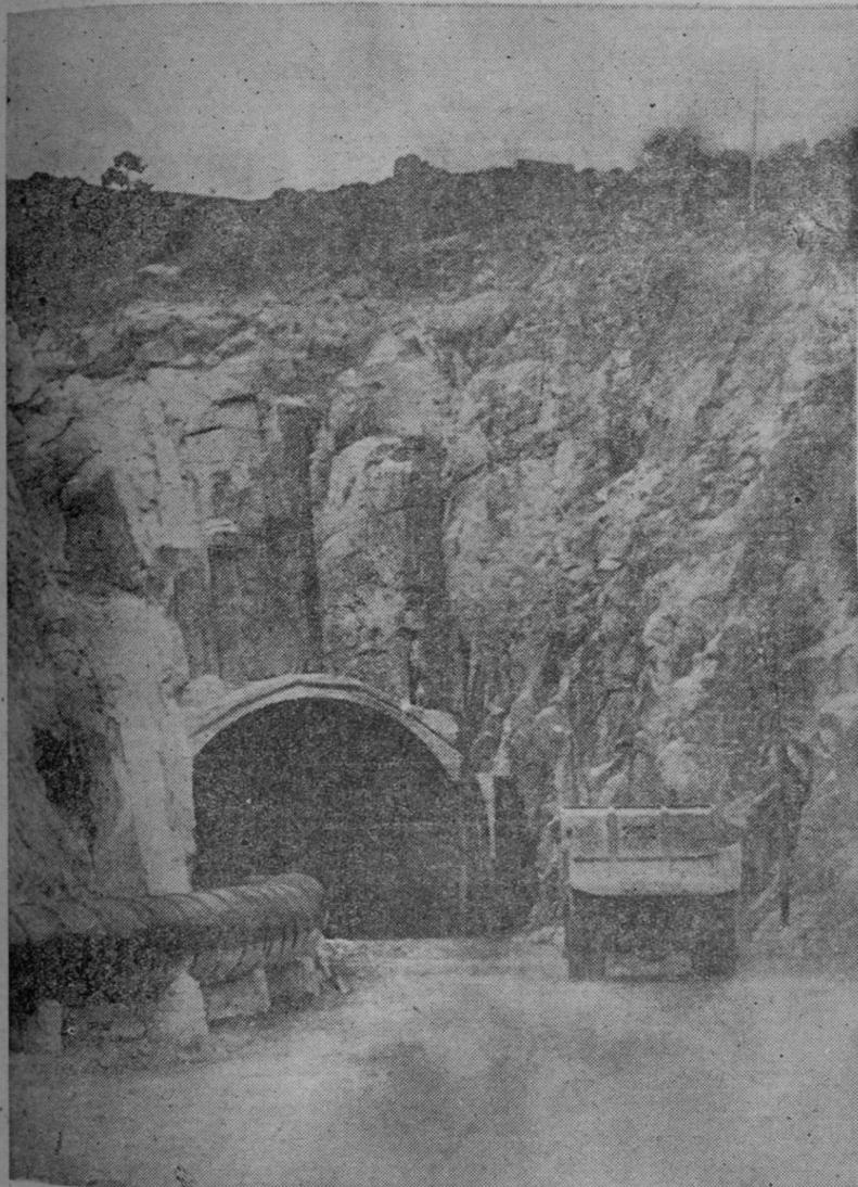
Por ambas bocas del túnel de Guadarrama ya circulan camiones. En la del norte llegan hasta los trescientos metros y en la del sur —a la que corresponde la fotografía— hasta rebasar los doscientos cincuenta. Son los de la empresa constructora, empleados en el transporte de la gran cantidad de piedra que los barrenos arrancan de las entrañas de la tierra.
