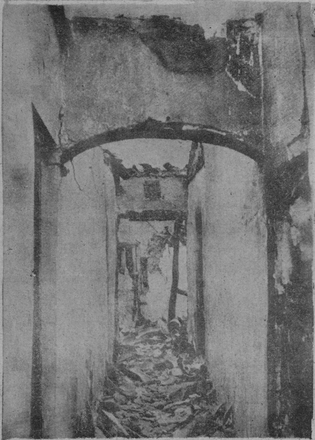
Nueva Villa de la Torre, de la provincia de Valladolid, ha sufrido un incendio, que, favorecido por el viento, destruyó casas y calles enteras. Un aspecto del incendio. Las pérdidas materiales son elevadas. — (Europa Press)
