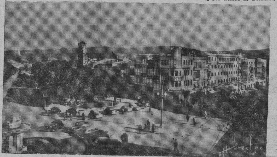
La Avenida Central de la ciudad de Braga, denominada del Mariscal Gomes da Costa
