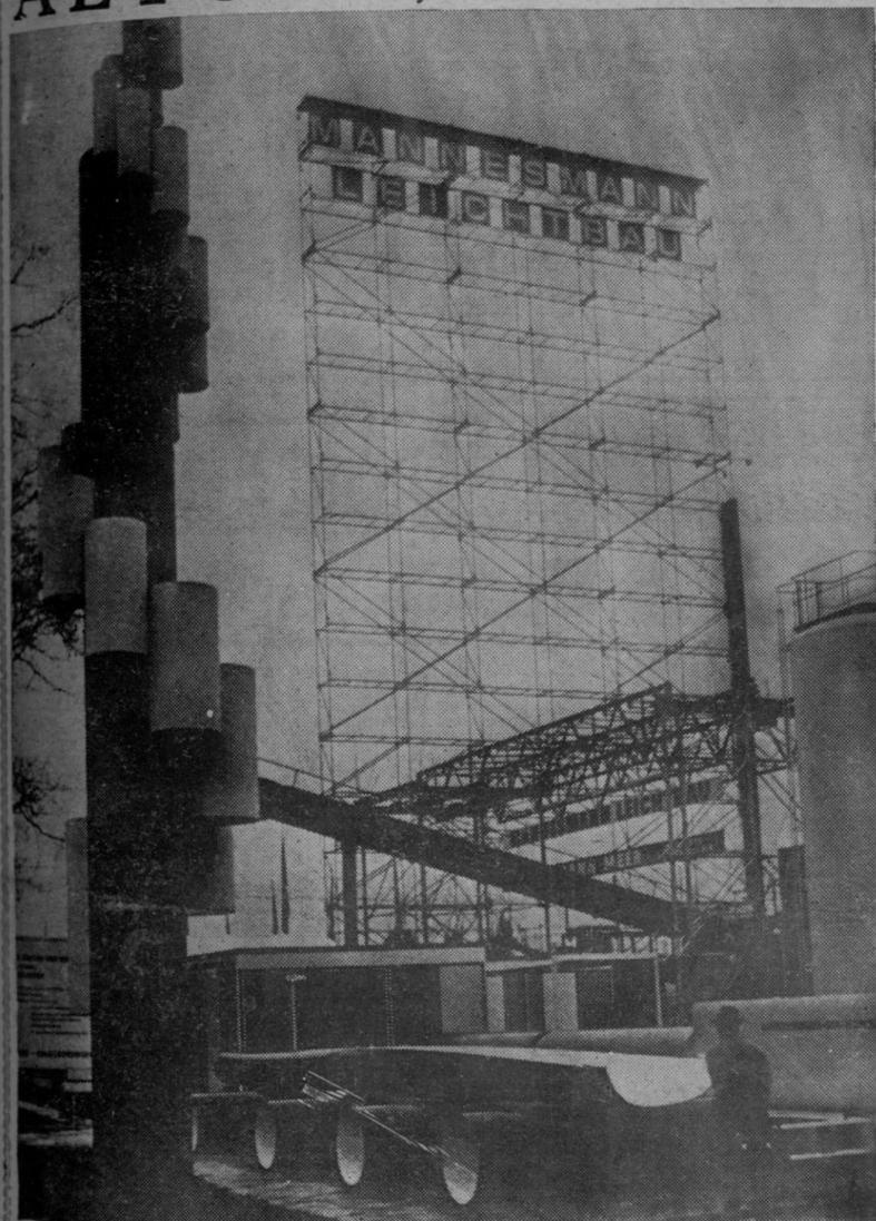
Quince pisos de altura tiene este andamiaje de erección rápida de la firma Mannesmann. El disco de andamiaje, dispuesto de modo completamente aislado, se aseguró mediante cables contra ráfagas. Figuró en la XVII Feria de Hannover, el «escaparate del mundo industrial», a la que concurrieron 27 naciones.—(Foto D.A.D.)
