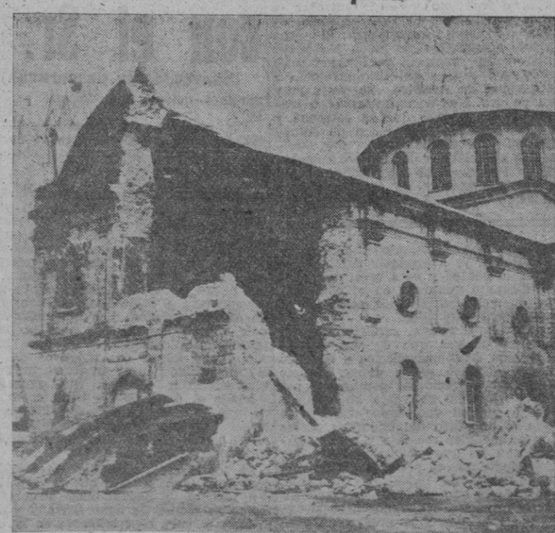
MADRID.—Estado en que quedó la Iglesia de la Inmaculada Concepción en Opon, isla de Panay, después del terremoto que se registró y que ha causado importantes daños. El movimiento sísmico duró tres minutos. (Foto CIFRA).
