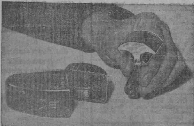
Nueva máquina de afeitar, no-eléctrica, que mientras se usa afila las dos hojas que funcionan con recorrimiento de tijera, en el interior de la guarda y pueden utilizarse durante varios años
