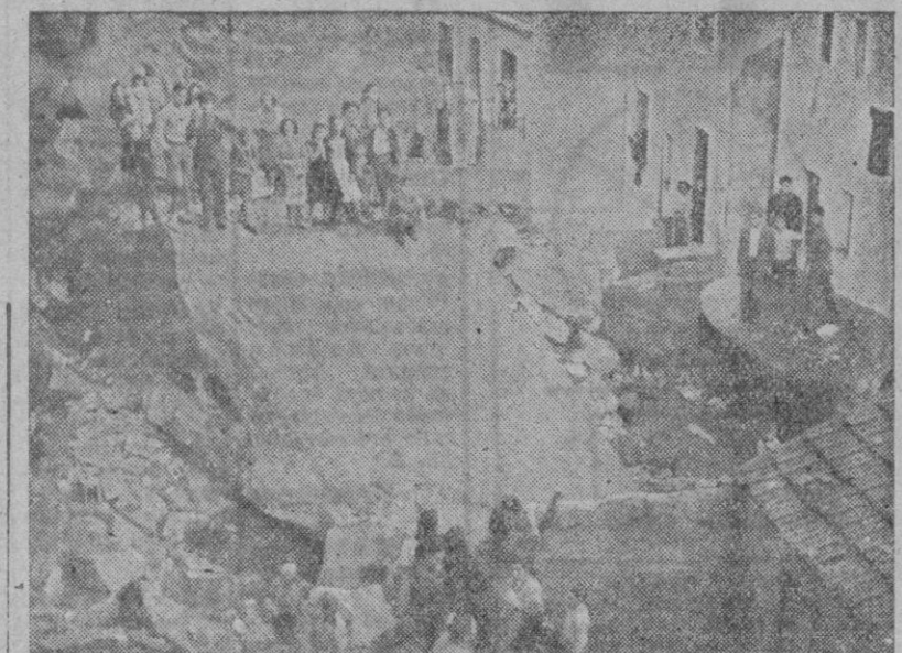
Varios vecinos contemplan en el lugar del suceso los trozos de roca que se desprendieron en la Travesía del Faro durante la madrugada de ayer.
