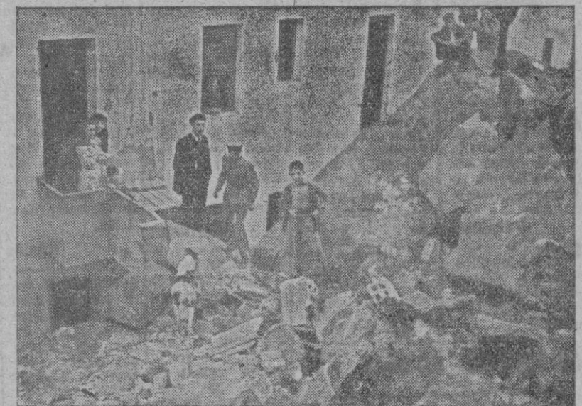
Uno de los bloques de roca desprendidos, que cayó sobre los muros de la casa número 23 de la Travesía de la calle de la Torre
