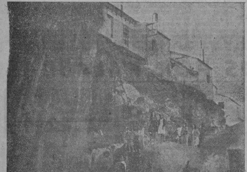
Estado en que quedó la casa de la Travesía del Faro al desprenderse el mirador, contiguo a las ventanas que aparecen en la fotografía
