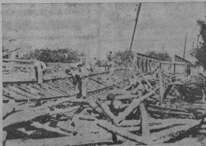
CASTELLON DE LA PLANA.— La corriente de las aguas arrastró hasta la vía férrea gran cantidad de troncos que causaron graves destrozos en la misma, interceptando las comunicaciones ferroviarias. En la fotografía varios obreros se ocupan en el arreglo de la línea.
