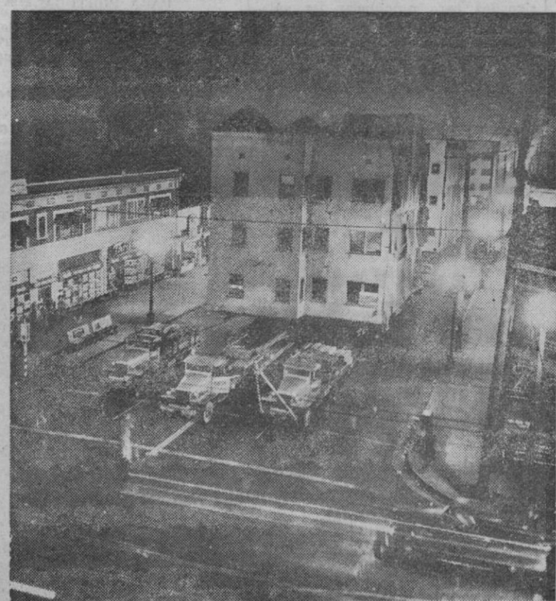
En la ciudad norteamericana de Los Angeles, un edificio de pisos, dividido en tres secciones, es trasladado a otro lugar remolcado por camiones, de noche, para no entorpecer el tráfico. Para los vecinos el traslado debe de ser muy divertido, todo lo divertido que resultará acostarse en un extremo de la ciudad y despertar en el extremo opuesto.
