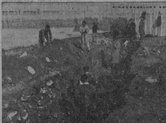
Prosiguen los trabajos para la cimentación del nuevo muro defensivo en Riazor. Como podrá apreciarse fácilmente por la foto, las obras se realizan varios metros a retaguardia del viejo muro, en parte derruido por el embate de las olas
