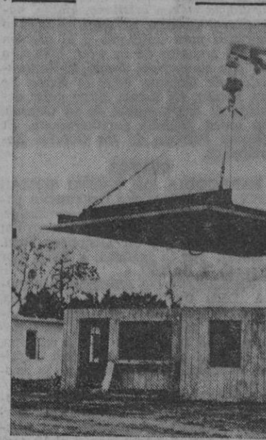
Durante las obras de construcción de una casa prefabricada en los Estados Unidos, una grúa coloca en su sitio el tejado, también prefabricado de hormigón, de 17 toneladas de peso, mediante un dispositivo a base de succión de aire, que no precisa el empleo de ganchos ni pernos.
