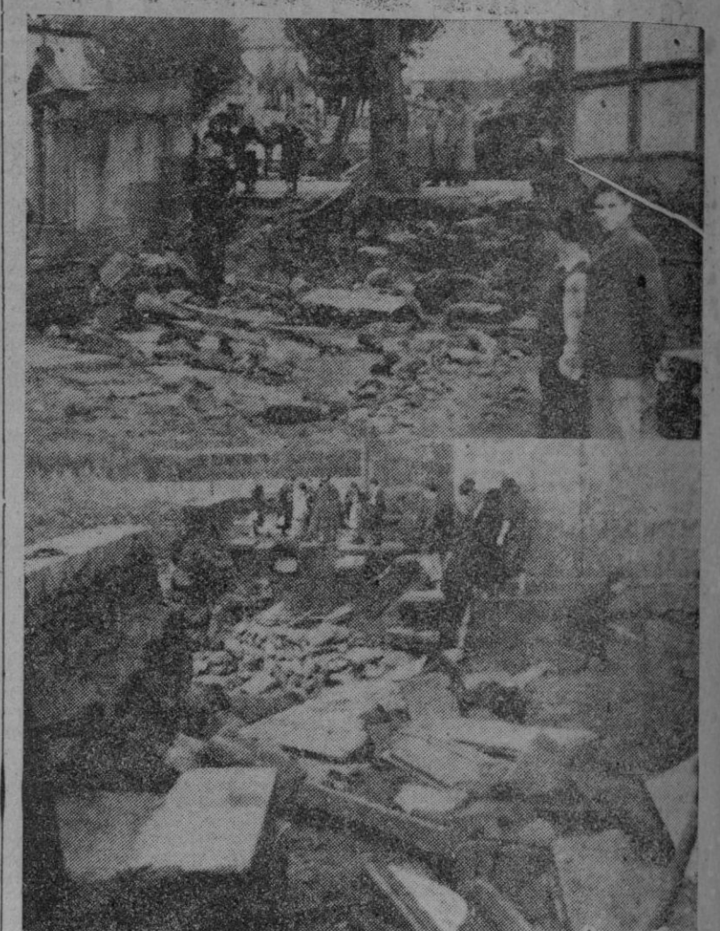
El temporal de agua desencadenado estos días ha ocasionado grandes daños en el cementerio de Puerto del Son. La torrencial destruyó los sepulcros y removió los despojos humanos, dejando el sagrado recinto en el lamentable estado que puede apreciarse por las fotos que nos envía Quintana.
