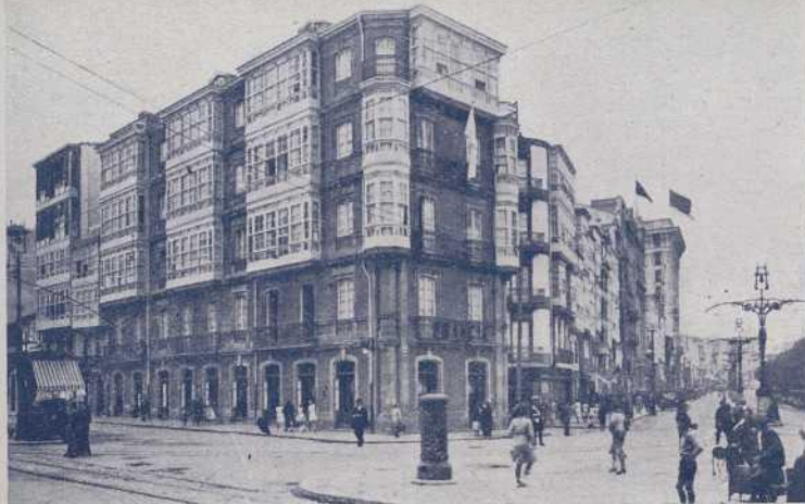
Plaza de Mina
