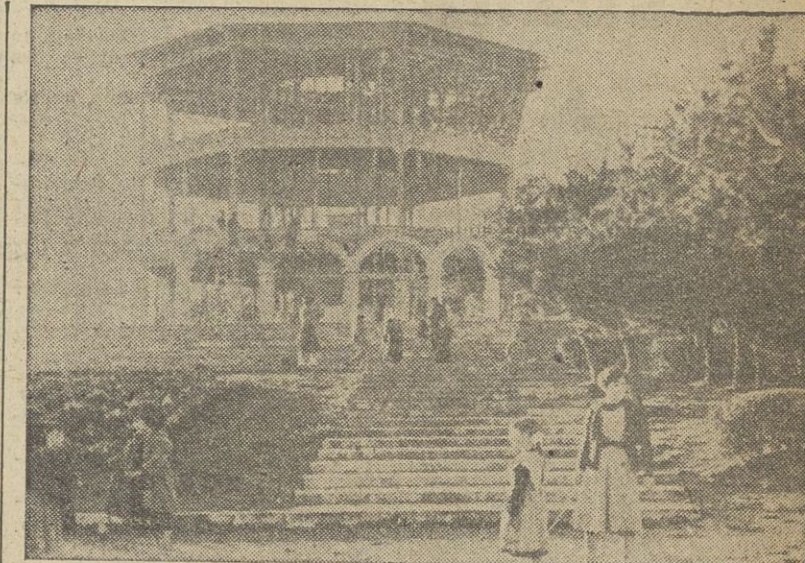
EL PALACIO DE LA LUZ. —El palacete que se construye en la cima del monte de Santa Margarita será el orgullo de La Coruña. Es una obra hermosa y de líneas bellas, abierta a todas las direcciones de la rosa de los vientos; bien puede llamarse el "palacio de la luz". Para llegar a él, una amplia escalinata de piedra.
