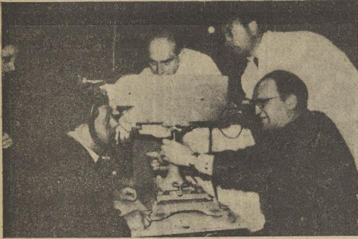
BARCELONA.—D. Cristóbal Garrigosa, inventor del moderno retinógrafo que aparece en la foto, en presencia de varios especialistas realiza las primeras pruebas del aparato que por un interesante procedimiento de iluminación permite obtener fotografías en color del fondo del ojo. El aparato que es el primero que se fabrica en el mundo puede aportar un notable avance en la ciencia oftalmológica.
