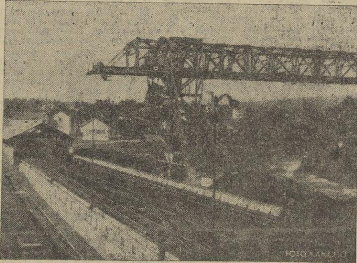
Puente-grúa móvil para distribución del carbón a los distintos parques de almacenaje. En primer término, la cinta sin fin que lleva el combustible machacado a la central
