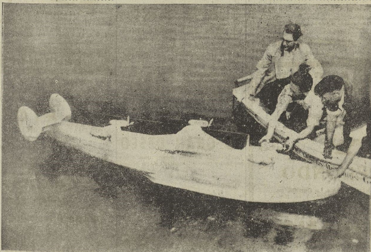
He aquí el modelo de avión "Super-baleana", de nuevo estilo, ideado por un ingeniero alemán, Wilhela Fechner, que, según dice, podría transportar mil quinientos pasajeros de Hamburgo a Nueva York, con una tripulación de 180 personas, en cincuenta horas. Va accionado con seis motores con una potencia de 38.400 caballos. (Foto A. P.)
