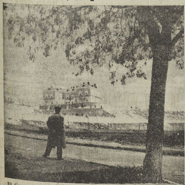
El Generalísimo Trujillo residirá en este reconstruido palacete de la Moncloa. En la foto, una vista del palacete tomada desde la carretera de La Coruña, y que da idea del magnífico lugar en que se halla (Servicio Edita por Santos Yubero).
