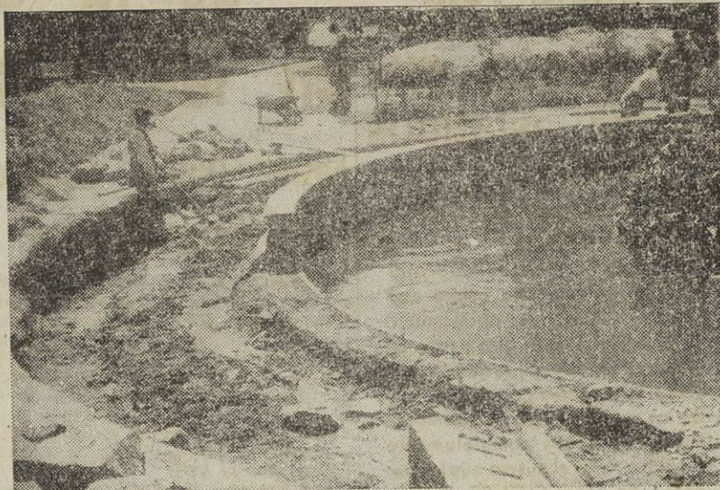
Estado actual de las obras que se ejecutan para la ampliación del estanque en el jardín de Méndez Núñez. El anillo pétreo ensancha su diámetro en cuatro metros y veinte centímetros (Foto EL IDEAL GALLEGU, por Cancelo)
