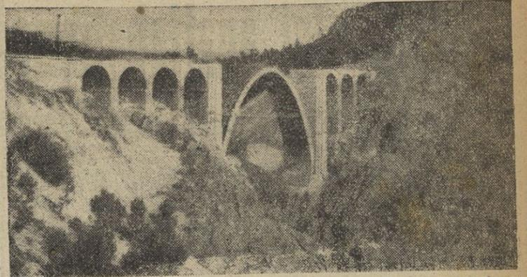
Estado actual del viaducto que se construye sobre el río Ulla, para el ferrocarril Orense-Santiago. La clave del arco central se halla a 94 metros de altura, y los estribos de este alarde de la ingeniería española se apoyan en la parte del Coto de Gundian (derecha) y en el risco de San Xuan da Coba (izquierda). La panorámica desde el viaducto es de las más sorprendentes de Galicia, por cuyo motivo está siendo muy visitado por los turistas. (Foto MOUGAN).
