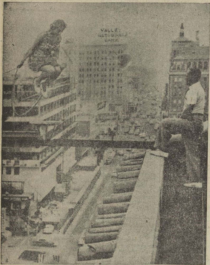
¿Correría usted ese riesgo inútil? Betty Fox salta a la comba en una pequeña plataforma sobre la calle y a la altura del piso número once. Su marido la observa con tranquilidad y aparente sangre fría. Parece seguro de que su mujer tiene cuerda para rato.
