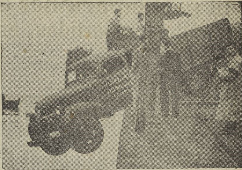
Un camión de la Fábrica de Cervezas quedó basculando sobre el muelle en la forma que puede apreciarse en la foto. Por un milagro no cayó al mar
