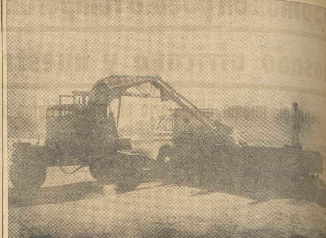
La mejor maquinaria trabaja día a día en este cargadero de mineral de hierro que dentro de breves tiempo estará terminado definitivamente. En la fotografía de Arjo la pala retira hacia el depósito —o silo— la carga del mineral. — (Foto ARJO)
