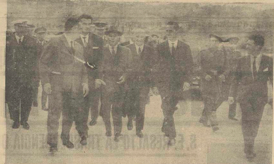
Franco acompañado del ministro de Industria y otras personalidades se dirige al mirador, para contemplar, en panorámica, la gigantesca presa, subestación, residencias y otras dependencias del salto de Belesar, el mayor de España. (Foto DANIEL).
