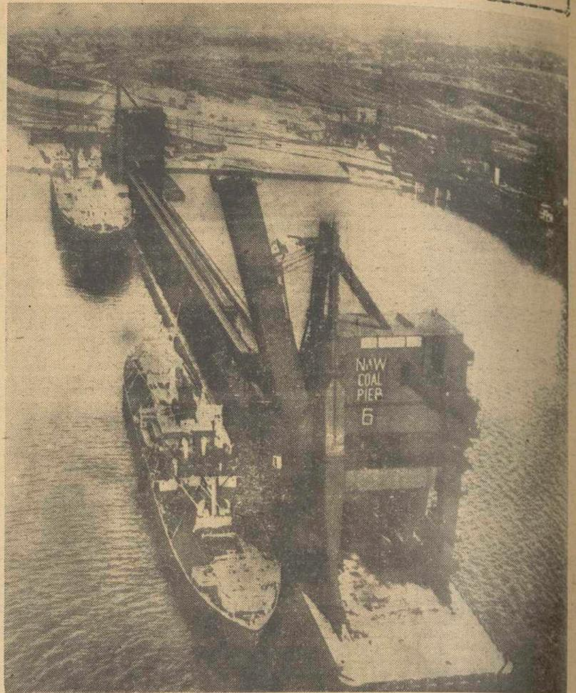
En el puerto de Norfolk, en Virginia se ha instalado este embarcadero para barcos de gran tonelaje. Desde el cuatro barcos pueden ser cargados simultáneamente y todos ellos a un ritmo de veinte mil toneladas por hora. Los dos barcos que aparecen en la foto están cargando carbón. — (Foto FIEL)
