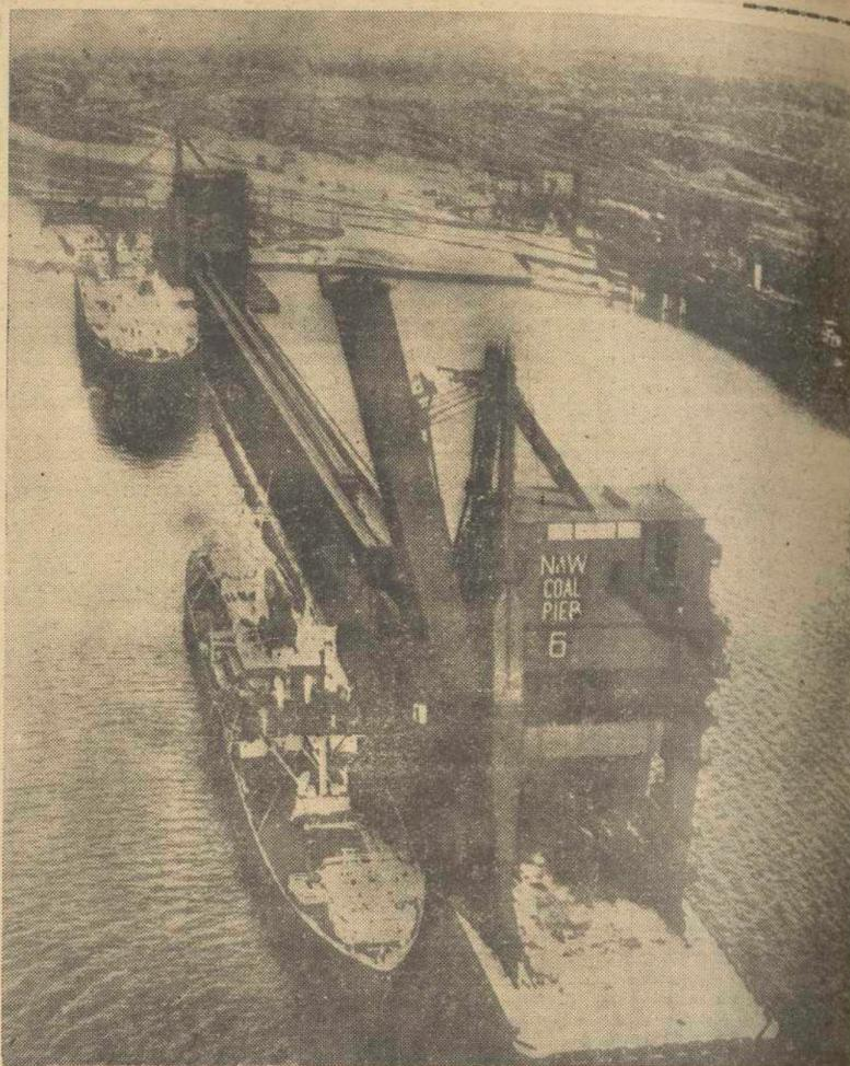
En el puerto de Norfolk, en Virginia se ha instalado este embarcadero para barcos de gran tonelaje. Desde él cuatro barcos pueden ser cargados simultáneamente y todos ellos a un ritmo de veinte mil toneladas por hora. Los dos barcos que aparecen en la foto están cargando carbón. (Foto FIEL)
