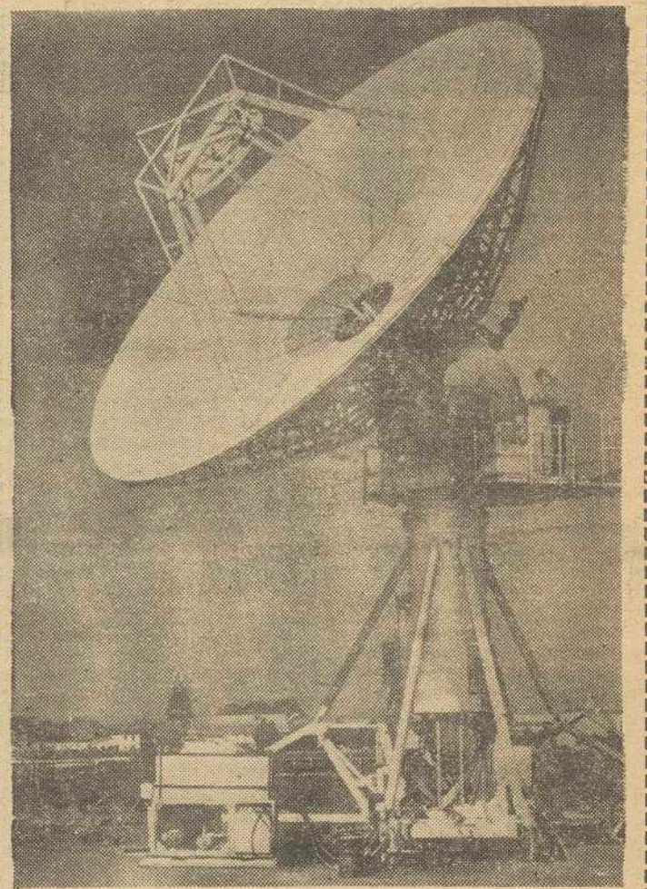
La primera estación terrestre alemana para la transmisión de telefonemas, telexes y datos a través de todos los satélites artificiales, del tipo «Telstar» y «Relay» fue inaugurada recientemente. La instalación consiste en una antena de espejos parabólicos de un diámetro de nueve metros y en un remolque para tractores-albarda, en que está instalado el sistema de control y de gobierno.
