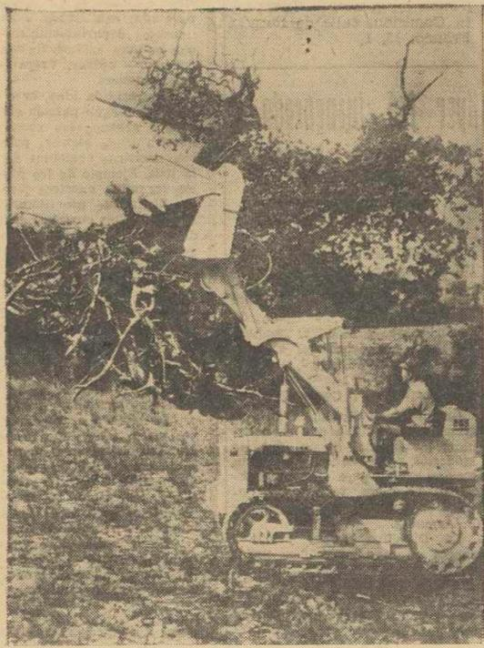
La excavadora denominada B-85, de fabricación británica. Es capaz de derribar árboles y otros obstáculos naturales, y puede emplearse con gran ventaja para explanación de terrenos o apertura de zanjas para cimientos.
