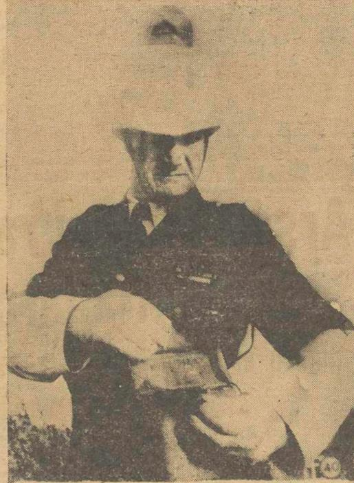
La policía de la ciudad inglesa de Derby está experimentando unos cascos que llevan una especie de faro en el casco que lanza destellos luminosos con el fin de hacer su presencia patente a los conductores durante la noche. La luz es alimentada por unas pilas situadas en una bolsa aneja al cinturón. Todo el equipo sólo pesa una libra (menos de medio kilo) aquí vemos a un policía-faro comprobando la carga de sus baterías. — (FOTOFIEL)
