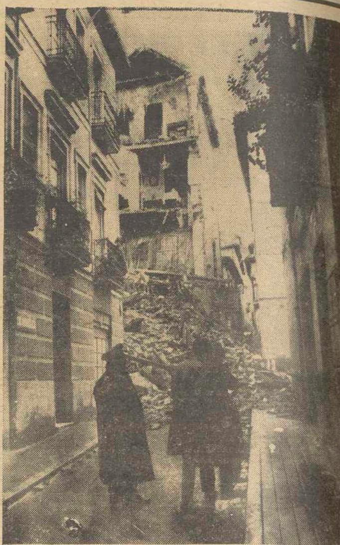
GRANADA. —Un temblor de tierra de no muy grande intensidad se ha notado en la ciudad. Aunque no ha habido daños de gravedad el seísmo se hizo notar en los pisos altos de la ciudad. Una casa, en la calle Varela, se derrumbó como consecuencia del seísmo, pero sus habitantes ya habían desalojado el inmueble debido a su mal estado. Un estado de la casa al derrumbarse la pared. — (Foto Europa Press)
