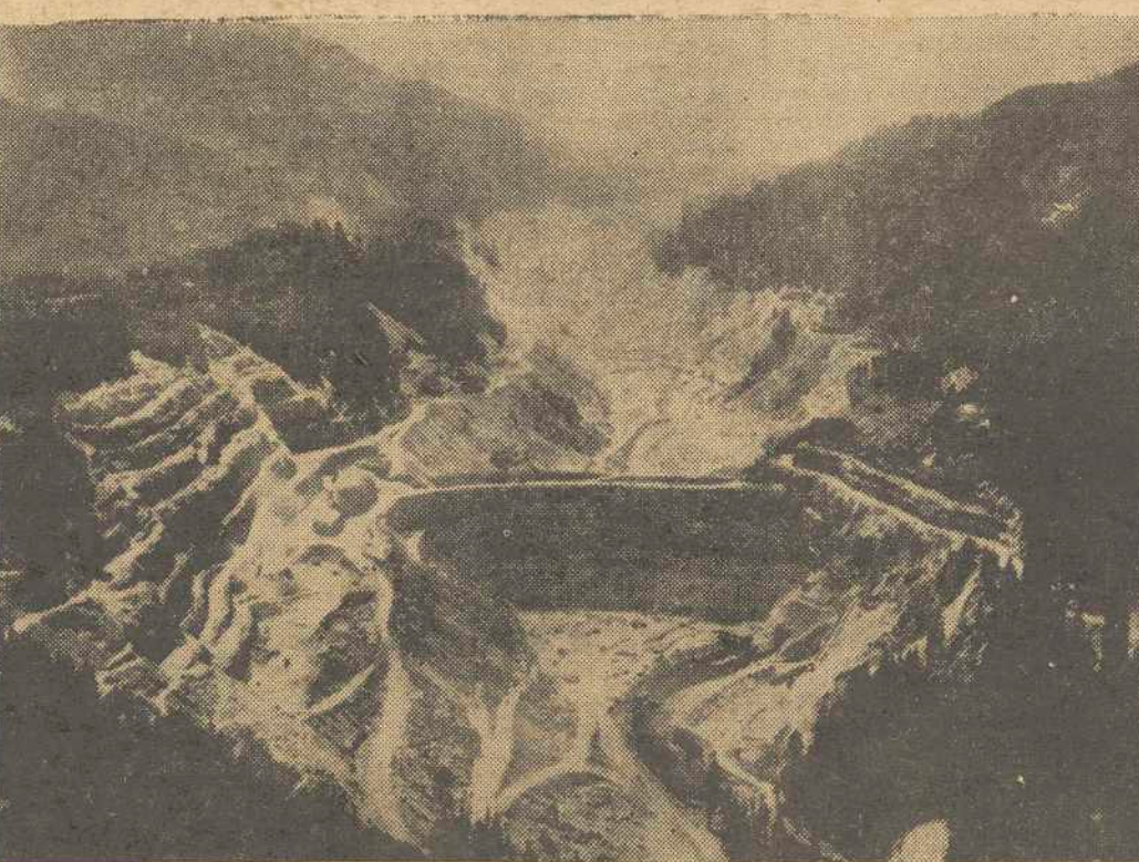
COUGAR (Oregón, EE. UU.). ... Una vista aérea de la gran presa construida en esta localidad que se encuentra ya en la fase final de las obras. Ha costado 55 millones de dólares y tiene una altura de 170 metros. ... (Foto Europa Press).
