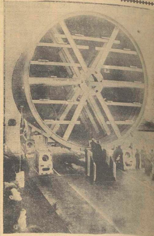
La quilla del «Resolution», el primer submarino británico lanzador de cohetes, que ha sido colocada recientemente en los astilleros de Barrow-in-Furness, Inglaterra. Consiste en una sección circular prefabricada que pesa bastante más de 100 toneladas. Es el primero de los cinco sumergibles Polaris propulsados con energía nuclear que va a construir la Gran Bretaña. (Foto LOGOS)
