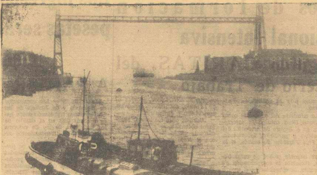
BILBAO. — Ha entrado en servicio la nueva barquilla del puente colgante entre Las Arenas y Portu-galete. La inauguración oficial tendrá lugar el próximo día 22 de mayo. En la foto, una perspectiva del puente y la nueva barquilla. (Foto Europa Press).
