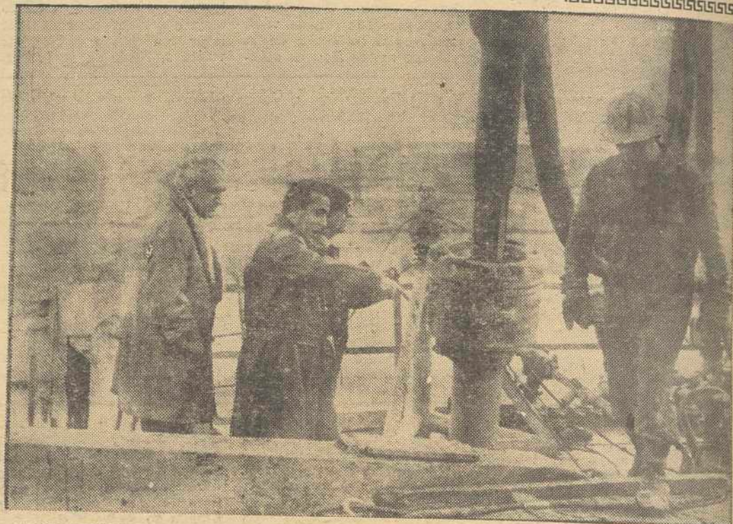
SARGENTES DE LA LORA (Burgos). — Con motivo de asistir a las pruebas del «Tester» de la segunda capa detectada en el pozo de Ayoluengo, llegaron procedentes de Madrid el Director General de Minas, don Joaquín Tarquiza; el ingeniero del Servicio de Hidrocarburos de la Dirección General, D. Antonio Ortiz; el subdirector de la Campsa, D. Justo de Larrea y el jefe de investigaciones de la Compañía, don Roberto Sanz, los cuales aparecen en la fotografía presenciando las pruebas extraídas que fueron negativas. — (Foto EUROPA PRESS)
