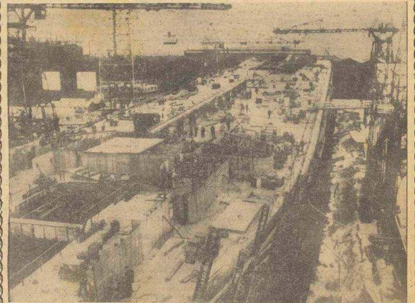
El petrolero de 100.000 toneladas, de una serie de dos construidos para la "British Petroleum", en las dos gradas nulas y acondicionadas para su construcción en los astilleros de la Vickers-Armstrongs de Darrow-in-Furness. Será botado el próximo año, con casi todas sus instalaciones ya montadas. Medirá 54 metros de manga, 278 de eslora y cerca de 15 de calado. — (FOTOFIEL).
